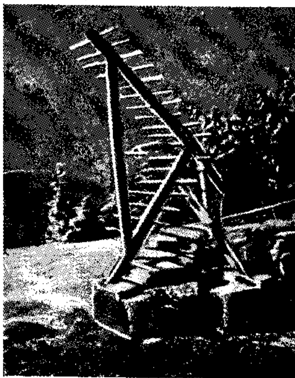
Рис. VIII. 4. 3. Внешний вид угловой антенны для волны 90 см.
