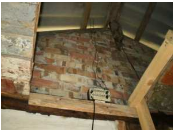
Фото 7. СУ для вертикала на крыше, емкости и индуктивности СУ переключаются тумблерами
